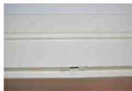
detail horní části zárubně se západkou pro zástrčku
